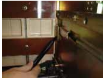
Feststehender Erdungskontakt in Kassette
